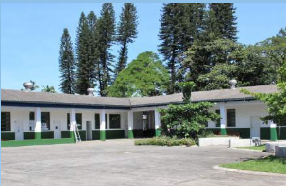
Vista da parte interna do Bloco A
