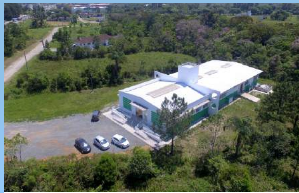
Vista aérea do Prédio da Anatomia
