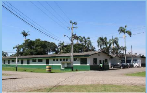
Vista lateral do Bloco A
